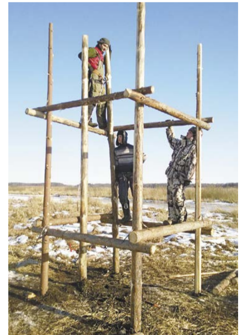
Строительство наблюдательной вышки в зоне затопления водохранилища у оз. Изможево. Фото Дениса Хабачева
